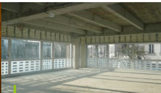
Isolation d'un mur rideau des façades d'un immeuble de bureau - Tours
