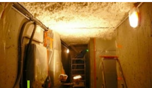
Isolation d'une sous face de plancher bas - Orléans
